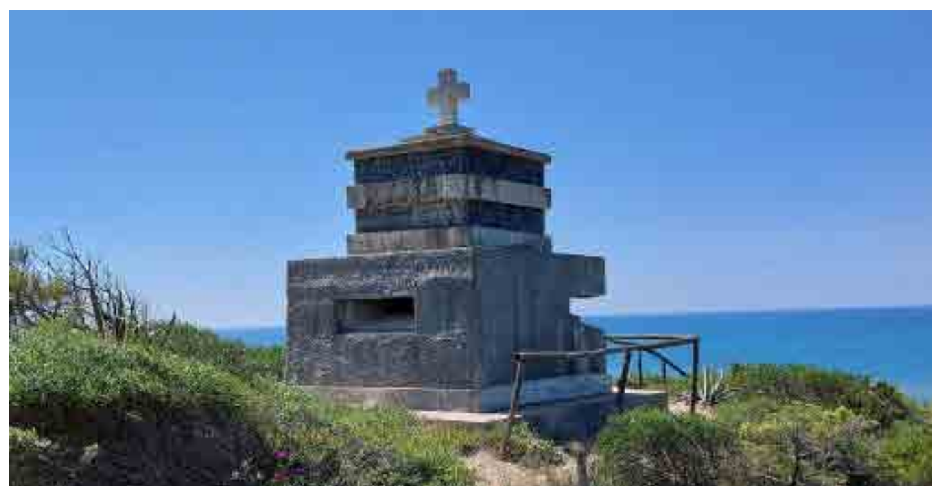
L'opera di consolidamento della duna realizzata da Francesco Tovo, affinché il Sacrario avesse maggiore stabilità
